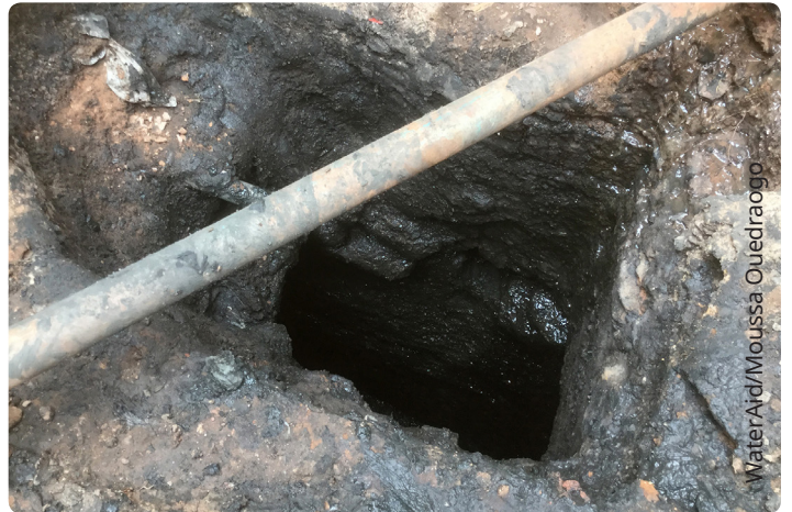
▲ Figure 7 : Fosse après la vidange à bobo.
