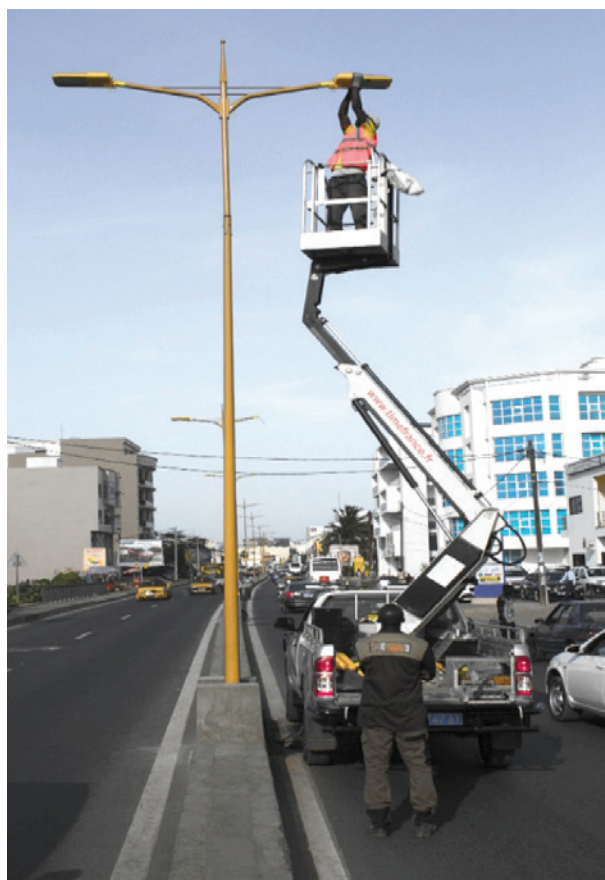
Entretien de l'éclairage public, Dakar, Sénégal.
